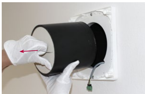
Herausziehen des Keramikwärmespeichers
