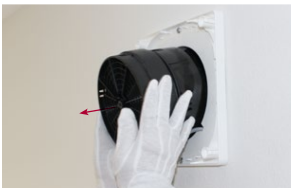
Herausziehen von inVENTron®: Leitwerke und Reversierventilator
